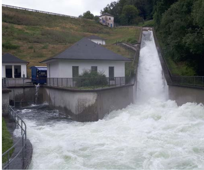
Bever-Talsperre: Überströmung der Hochwasserentlastung
